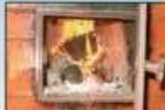
Своевременно проверяйте исправность печи и дымохода (удалите сажу, заделывайте трещины, белите дымовую трубу на чердаке и выше кровли).
